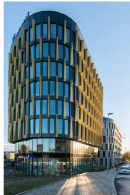
AFI Vokovice Prag, Tschechien LEED Platinum zertifiziert
