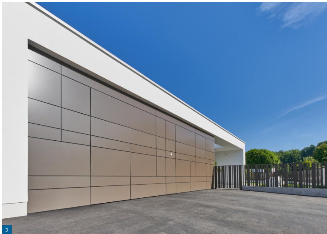
1. Modernes Tor bauseitig befüllt mit Alucobond-Platten // 2. Bauseitige Verkleidung beim Design-Tor mit Alucobond
