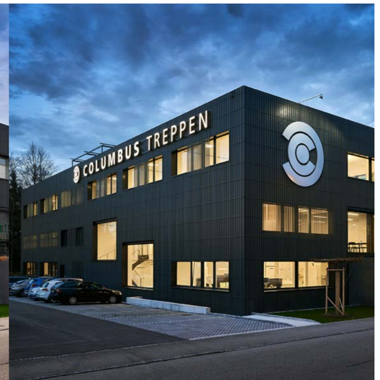
Columbus Treppen, Oberbüren (CH) ↗
