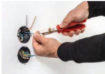
**Schritt 1:** Bestehende Steckdosen werden entfernt. Die vorhandenen Leitungen können genutzt werden.
