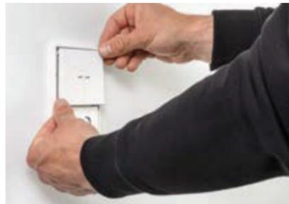
**Schritt 3:** Rahmen und Aufsätze werden aufgesteckt.
