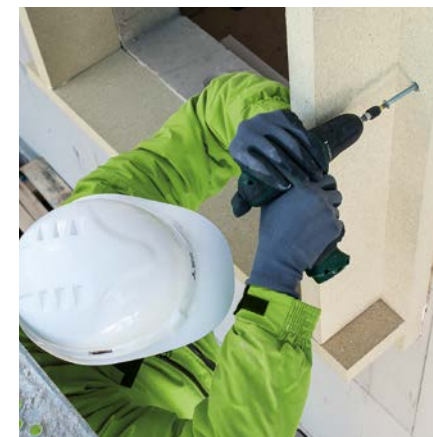
Abb. 7: Sichern Sie alle Zargen mit Rahmenschrauben, um ein Abrutschen zu verhindern.
