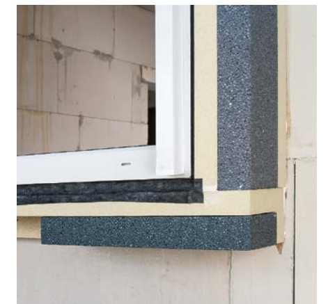
Abb. 9: Verkleben Sie unter der Außenfensterbank eine ME500 TwinAktiv Folie gegen drückendes Wasser. Bei Bedarf können die Zargen mit dem passenden PR008 Dämmkeil ergänzt werden.
