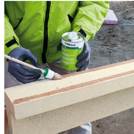
Abb. 3: Reinigen Sie alle Klebeflächen und behandeln Sie diese mit illbruck AT140 Primer vor.
