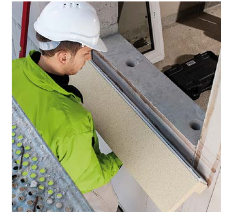
Abb. 6: Drücken Sie die Zarge sorgfältig an das Mauerwerk und richten Sie diese aus.
