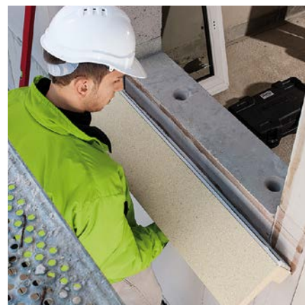
Abb. 6: Drücken Sie die Zarge sorgfältig an das Mauerwerk und richten Sie diese aus.
