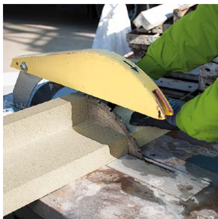
Abb. 1: Schneiden Sie die Zargen zu.
