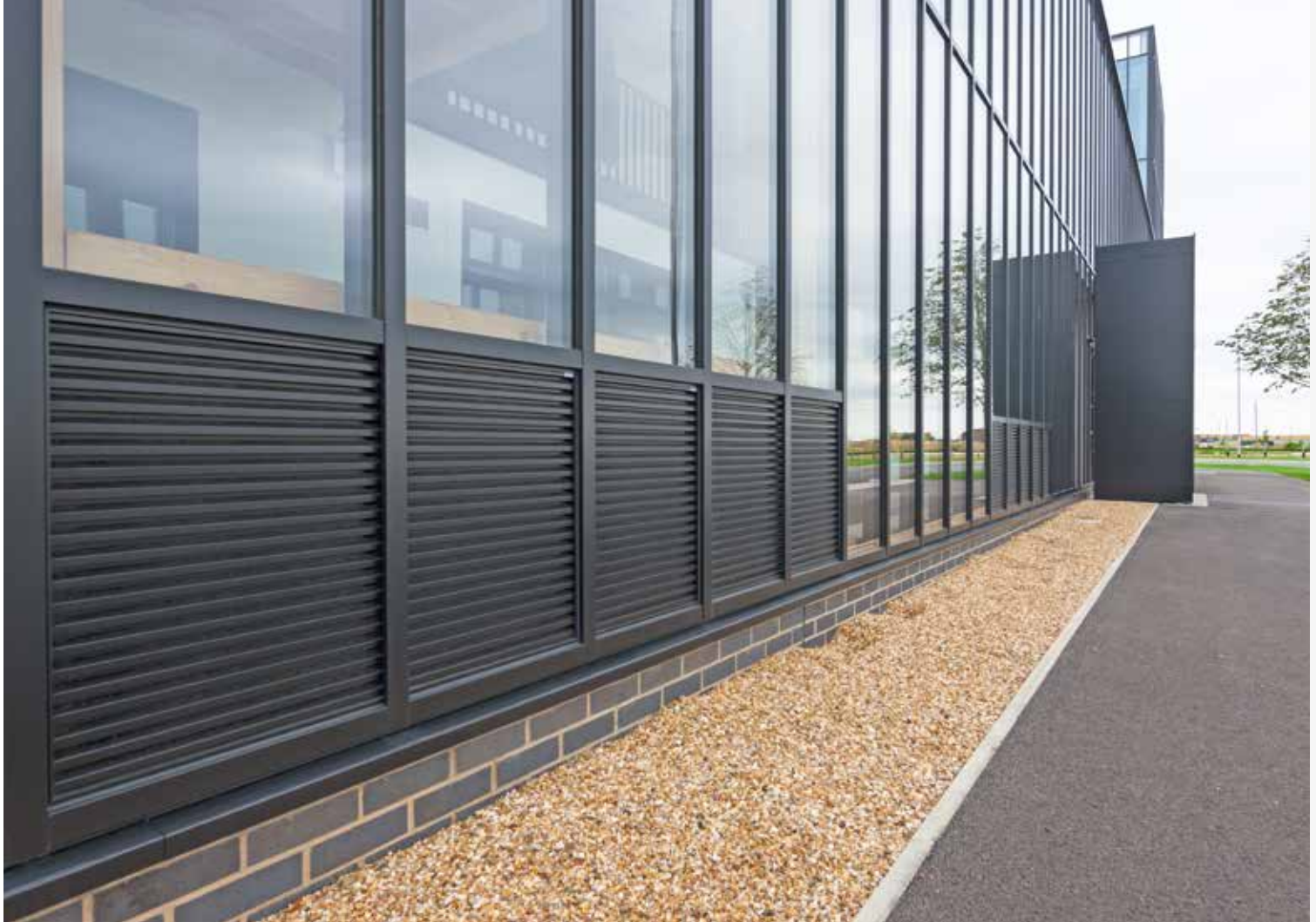
414 - Lüftungsgitter Eingesponnt
