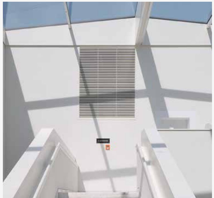
481 - Lüftungsgitter Einliegend schwere Ausführung
