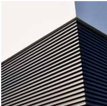
Bei Ecken werden die Lamellen exakt auf Gehrung gesägt, damit sie bei der Montage passgenau anschließen und eine ästhetische Lösung bieten.
