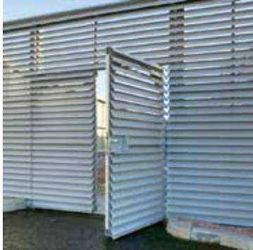
Renson® bietet nach innen und nach außen öffnende Einzel- oder Doppeltüren auf Maß an. Je nach Bedarf können Durchgänge in das Lamellenwandsystem integriert werden, z.B. zur Wartung von sich dahinter befindenden industriellen Anlagen. Die Türen werden auf Wunsch mit Schlössern, Flachscharnieren, Türgriffen und Sicherungsketten ausgestattet.
