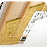
Dämmung zwischen den Sparren im Steldach
