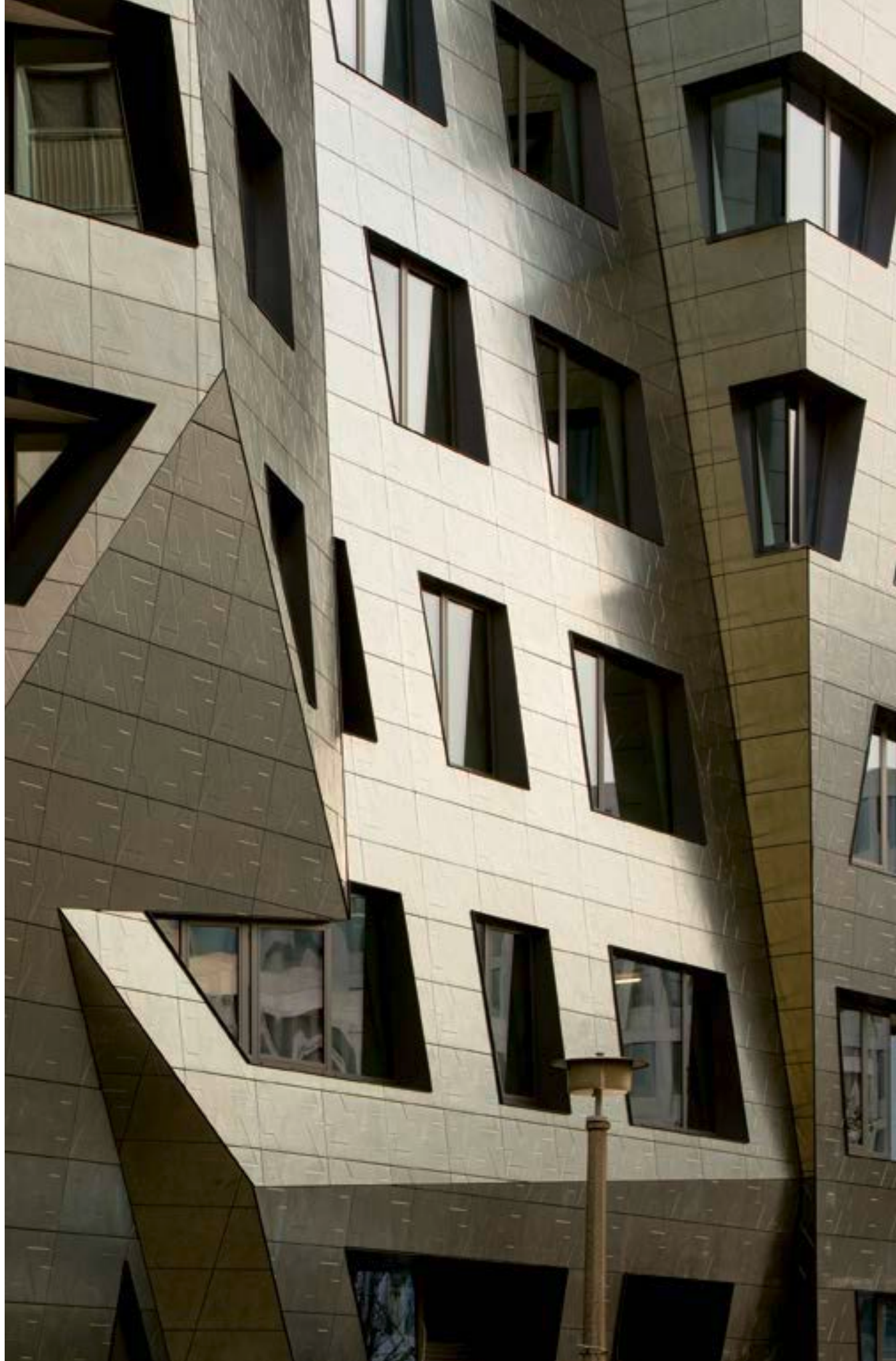
Die Fliesen der Fassade wurden teils um 180° gedreht, um das repetitive Muster zu brechen. Die Linien setzen sich dabei dennoch immer fort.
