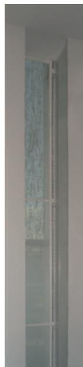
Für Elementbreiten < 450 mm waren keine motorischen Rollos möglich. Auch handbediente Kugelkettenrollos schieden aufgrund des ungünstigen Breiten-Höhen-Verhältnisses aus.
