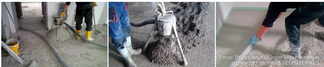
Fördern und Einbringen mit der Estrichpumpe
