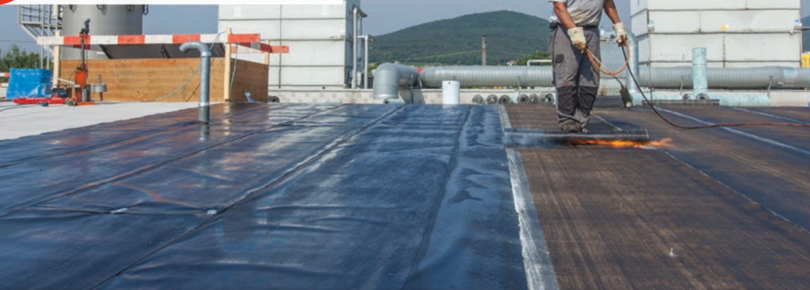
Nahtschweißung mit Handschweißgerät
