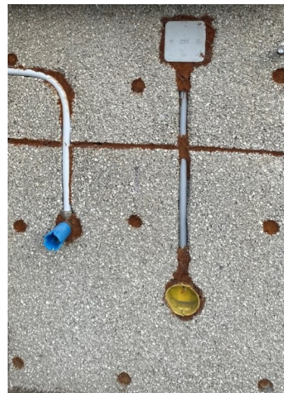
Abbildung 3: Montage von Leitungen
