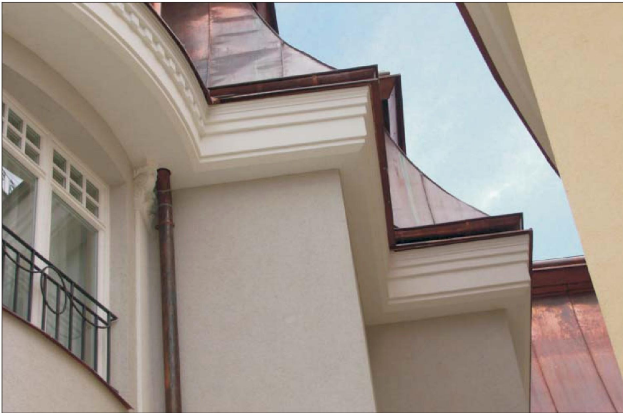
Grand Spa Hotel Marienbad, Villa Ferdinand Prottelith-Traufengesims Realisierung 2003 – 2004
