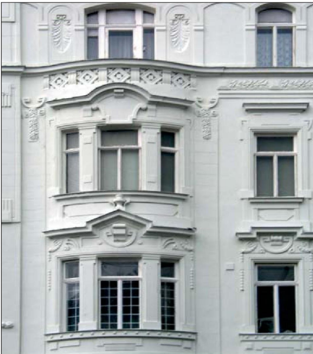
Porzellangasse Wien, Fassadendetail
