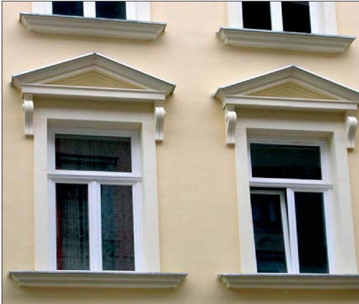
Strobachgasse Wien, Gesims
