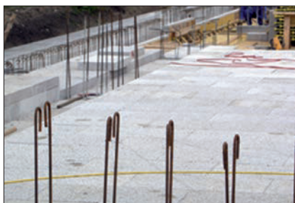
Eingelegte Dämmplatte
