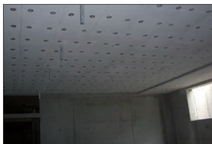
Dämmplatte gedübelt / geschraubt
