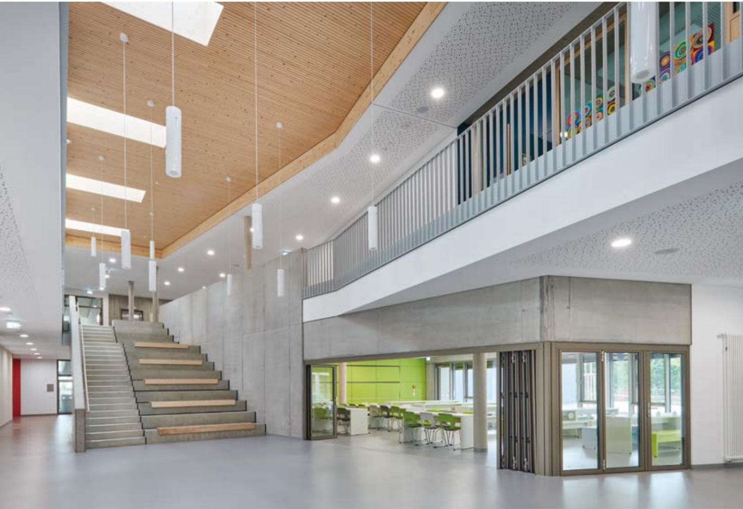
„Der graue Kautschukbelag greift die Farbigkeit des Sichtbetons auf, was eine optische Verbindung zwischen Boden und Decke schafft. Durch die homogene Oberfläche und die unverfugte Verlegung bringt der Bodenbelag optisch Ruhe ins Gebäude.“
