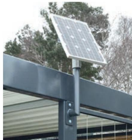
▲ Solarmodul an Warthallenstütze befestigt
