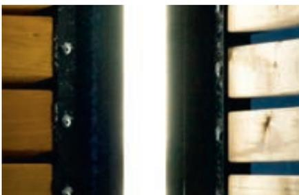
▲ Stützenblende hinterleuchtet mit LED-Lichtleiste
