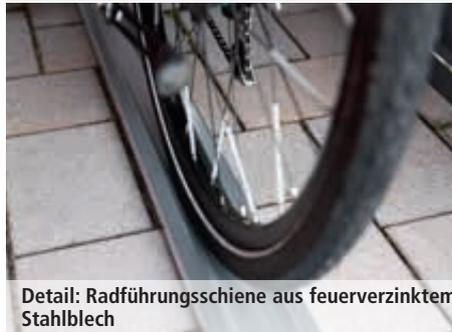
Detail: Radführungsschiene aus feuerverzinktem Stahlblech
