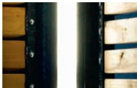
▲ Stützenblende hinterleuchtet mit LED-Lichtleiste
