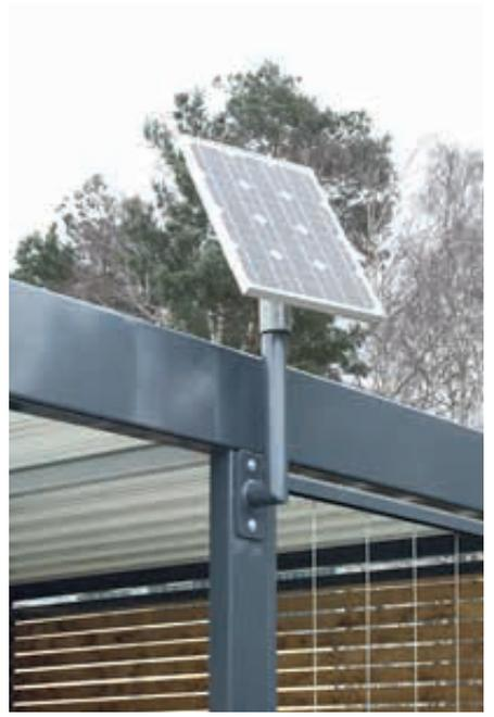
▲ Solarmodul an Warthallenstütze befestigt
