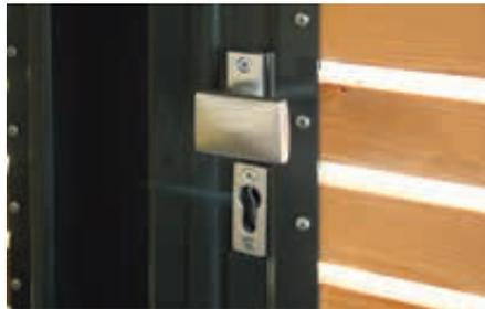
▲ Schiebetür geschlossen, Innenansicht, Drückergarnitur drehbarer Knauf
