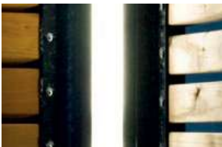
▲ Stützenblende hinterleuchtet mit LED-Lichtleiste
