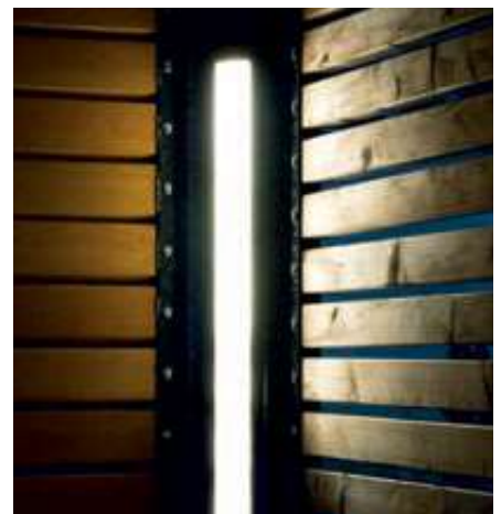
▲ Stützenblende hinterleuchtet mit LED-Lichtleiste
