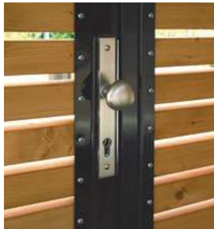
▲ Drehflügeltür, zweiteilig, Innenansicht, Drückergarnitur drehbarer Knauf
