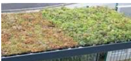
▲ links: Dachbegrünungssystem Economy, rechts: Dachbegrünungssystem Premium
