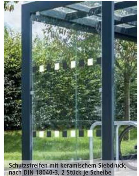
Schutzstreifen mit keramischem Siebdruck, nach DIN 18040-3, 2 Stück je Scheibe
