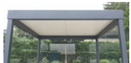
▲ Detail: Dachunterseite aus Sandwichelementen
