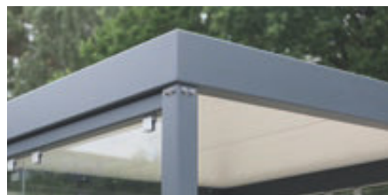
▲ Detail: Stützenverbindung mittel Edelstahlschrauben
