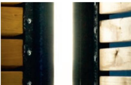
▲ Stützenblende hinterleuchtet mit LED-Lichtleiste
