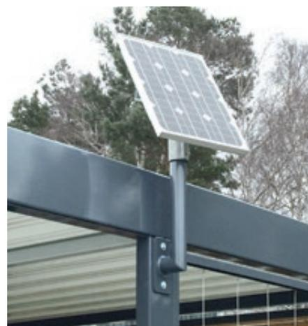
▲ Solarmodul an Warthallenstütze befestigt
