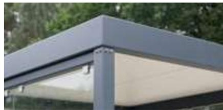
▲ Detail: Stützenverbindung mittel Edelstahlschrauben
