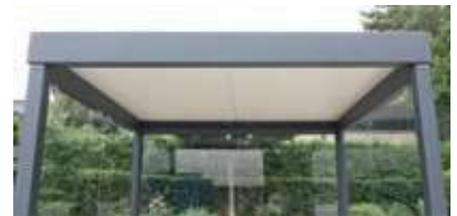
▲ Detail: Dachunterseite aus Sandwichelementen
