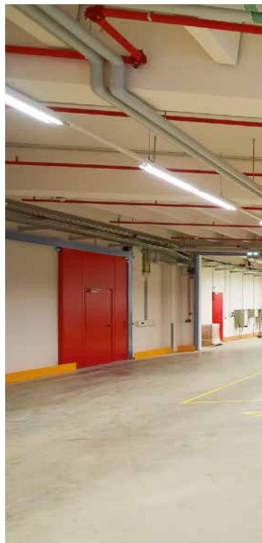
UNTEN RECHTS. Feuerschutz-Schiebetor FST 30-1 OD, 1-flügelig, Schlupftür, Feuerrot RAL 3000
