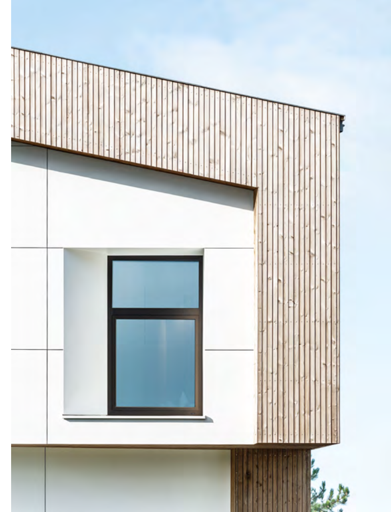
Unsichtbare Befestigung mit dem Swisspearl Sigma 8 Pro System
