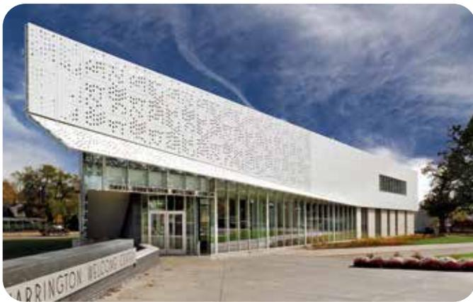
Produkt: Largo Fassadenplatte Carat mit Perforation
