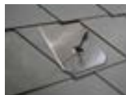
Einbau bei ED Rhombus 400x440
