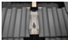
Die weiteren Dachsteine beiseite schieben
