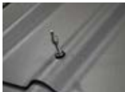
Stockschraube bei Structa Dachplatte
