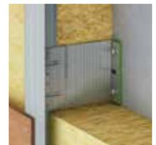
Die ENSAVE Systeme ermöglichen die Montage mittels Schrauben und Nieten
