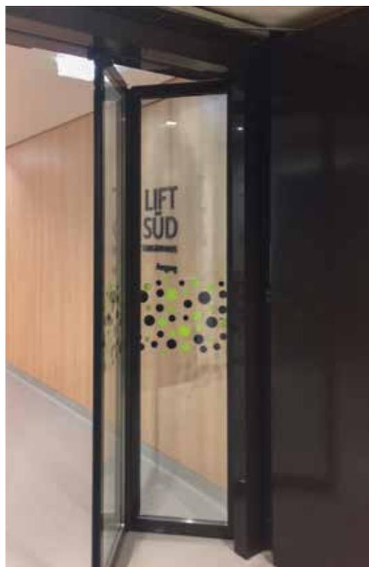
Ob bei Kälte oder Hitze, die Faltsflügeltüren **FFT FLEX Green** verfügen über eine hocheffiziente thermische Trennung mit sehr guten Wärmedurchgangswerten. In Verbindung mit hochwertigen ISO-Gläsern sorgen die Türen für eine hervorragende Wärmedämmung des Bauabschlusses.
