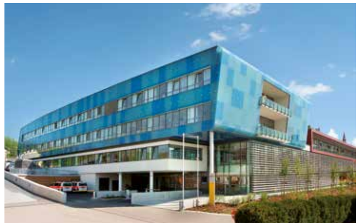
Landeskrankenhaus Mostviertel, Melk
