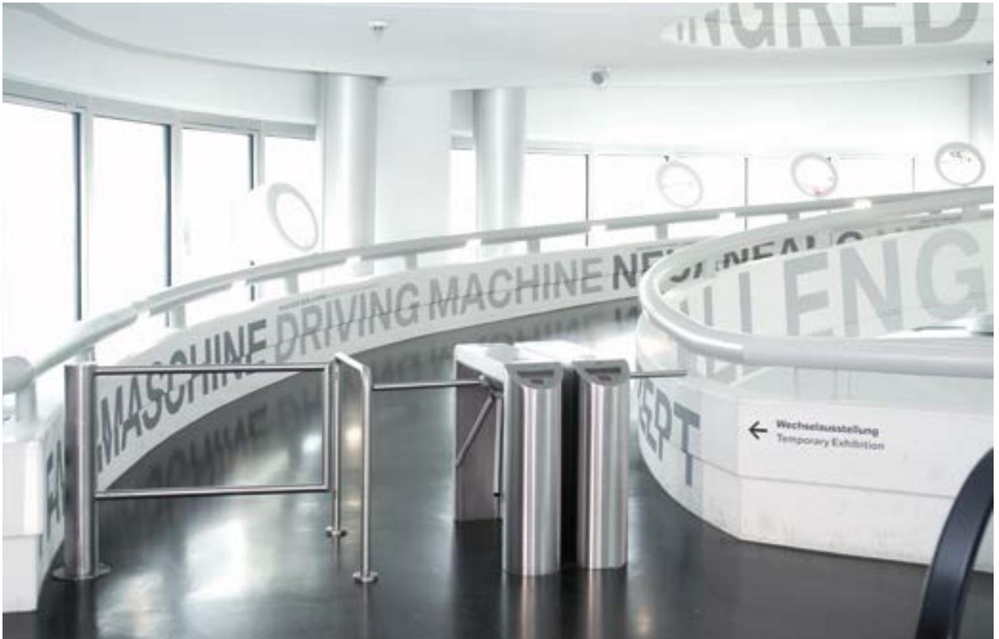
Halbhohe Drehsperrren übernehmen zur Entlastung des Empfangspersonals die Zugangskontrolle in Eingängen zu Büro- oder Verwaltungsgebäuden, Industrieanlagen, Banken, Behörden und vielen Sport- und Freizeiteinrichtungen. Sie sind schnell, zuverlässig und einfach zu bedienen.
