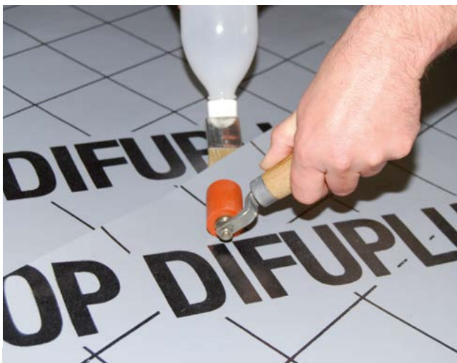
Kalt - mit Quellschweißmittel
