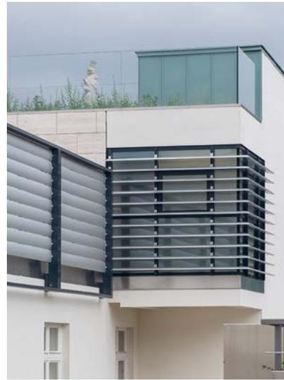
13 **Park Hyatt Vienna** – Stiegen, Stiegegeländer, Nurglas-Geländer, Kräutergarten, Lamellenkonstruktionen – Aluminium-Systeme beschichtet, Stahl beschichtet, Nirosta geschliffen und poliert, Black Inox, Aluminium-Sondereile beschichtet
