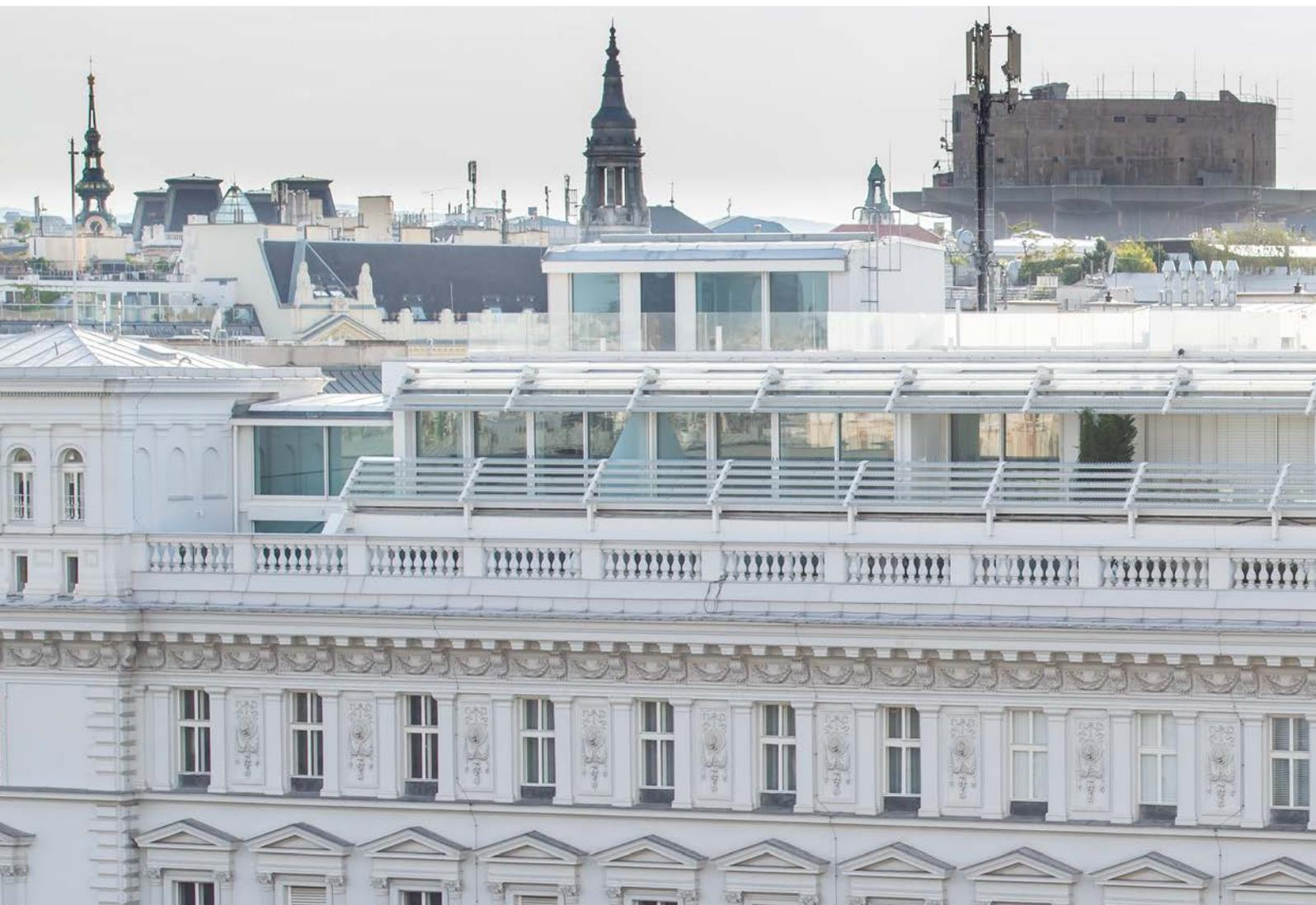
17 **Dachgeschoßausbau Schillerplatz** – 600 t Stahlbau, Glasfassaden und Brandschutz
