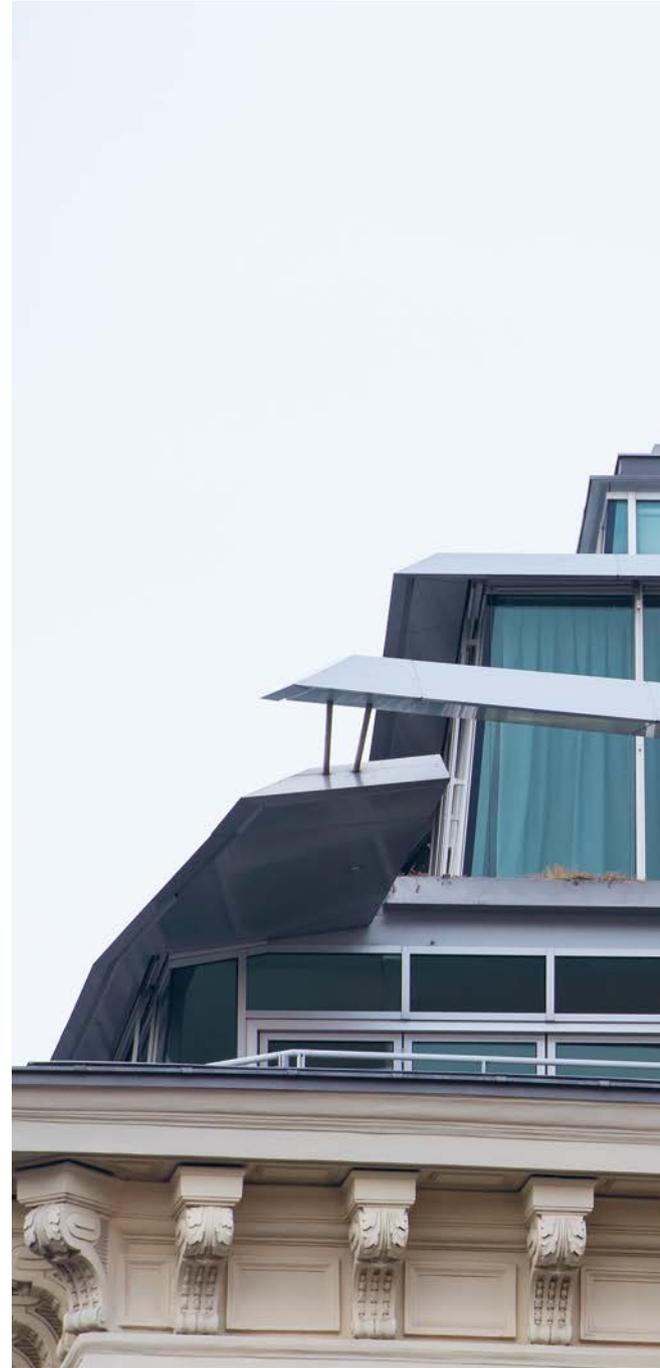
18 **Dachgeschoßausbau Nibelungengasse** – Asymmetrische, zweigeschoßige Konstruktion – Aluminium, Glas, Stahl, Alucobondflügel
