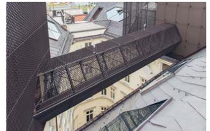
14 **Oesterreichische Kontrollbank** – Trigonfassade, wabenförmige Fenstergeometrie – Aluminium-Glas-Konstruktionen
