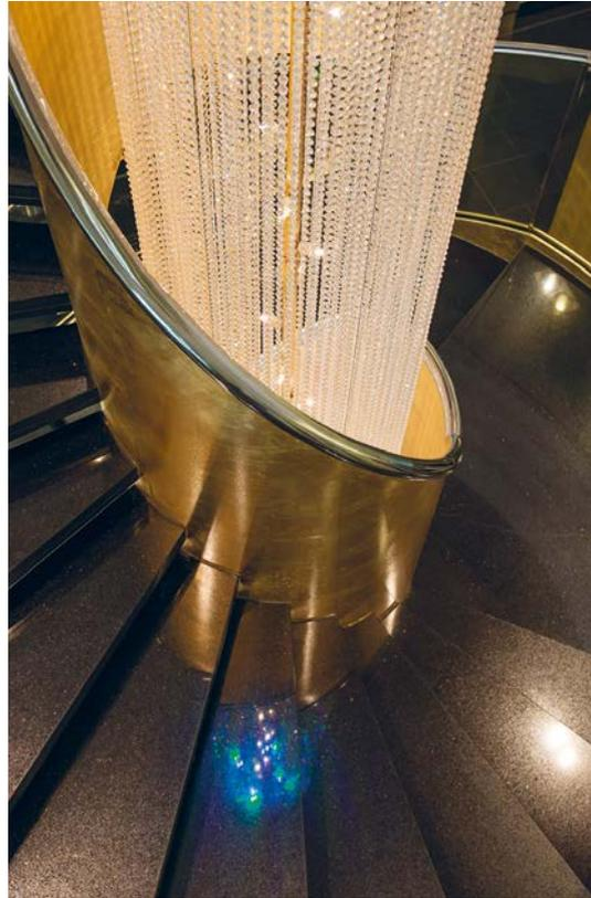
3 **Popp & Kretschmer** – Wendeltreppe und Stieengeländer – Stahl verzinkt, Stahl vergoldet, Nirosta poliert, Nirosta Titanitrid-beschichtet, Messing poliert, Messing vergoldet
