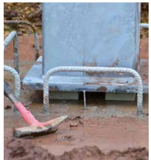
▲ Peikko Verbundstützen werden als Halbfertigteil-Elemente mit den erforderlichen Anschlüssen geliefert und können abstützungsfrei montiert und ausgerichtet werden.
