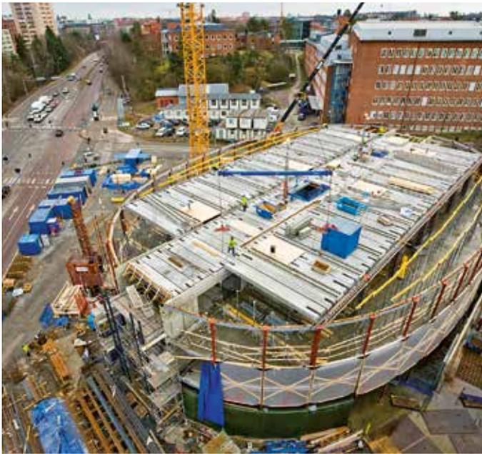
▲ Die DELTABEAM® Verbundträger sind entlang der Fassade und als Tragbalken zwischen verschiedenen Rahmentragwerken angeordnet. Insgesamt wurden 2.400 m DELTABEAM® auf die Baustelle geliefert.
