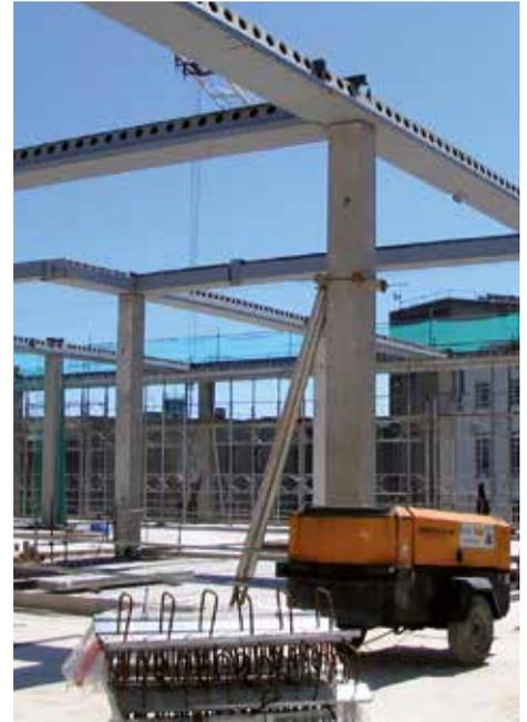
Stützen am weitesten voneinander entfernt. „Die Deckenbelastung ist relativ gering und gleichmäßig verteilt“, erläutert Allen. „Das bedeutet, wir konnten für die Parkbuchten eine sehr offene, freie Fläche schaffen und haben dafür 16 m lange Hohldielen verwendet.“
