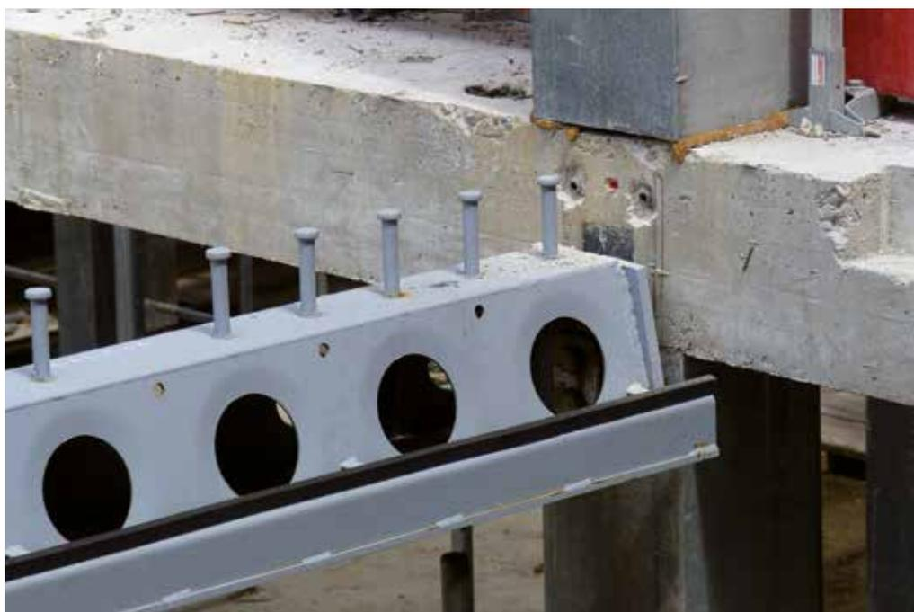
▲ DELTABEAM® Verbundträger werden mit PCs Konsolen an aufgehende Betonbauteile angeschlossen. PCs Konsolen ermöglichen eine durchgehende, glatte Schalung.
