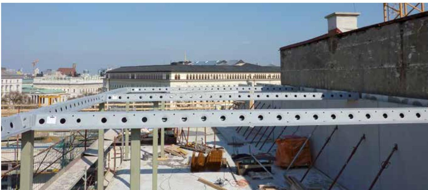
vorhandenen Aussteifungspunkten. Es musste die horizontale Scheibenwirkung unbedingt vorhanden sein, damit die Gesamtkonstruktion wirken kann.
