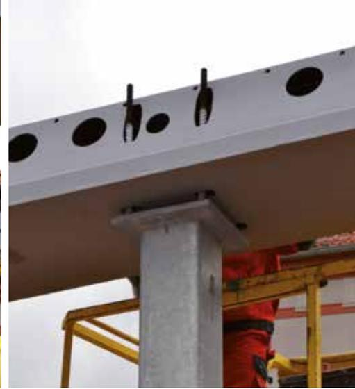
▲ Durch die perfekte Abstimmung der Bauteilanschlüsse aufeinander können die vorgefertigten Verbundträger mit geringem Zeitaufwand auf den bereits im Montagezustand tragenden Verbundstützen montiert werden.
