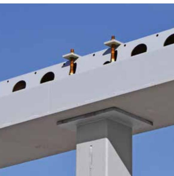
▲ Alle Komponenten der DELTABEAM® Frames lassen sich mittels maßgefertigten Anschlüssen miteinander verbinden.
