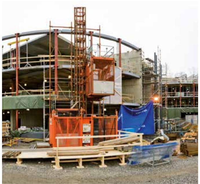
▲ Die geschwungene Außenwand hat sich als Herausforderung erwiesen, da das Ende des Trägers in Relation zur Stütze abgeschrägt war, so dass das Befestigen zunächst kompliziert erschien. Es ist uns jedoch gelungen, eine standardisierte Lösung zu entwickeln, die leicht wiederholt und für den gesamten Bau verwendet werden konnte.
