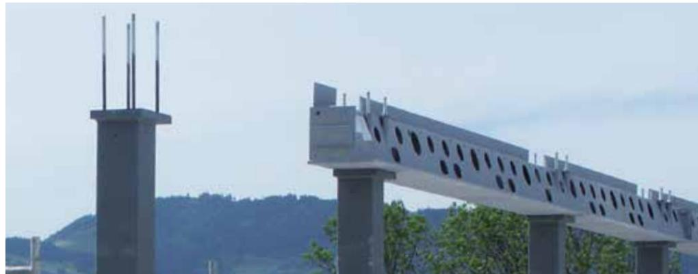
▲ Mit der Systemkombination konnten bis zu 16 Meter stützenfrei überspannt werden.
