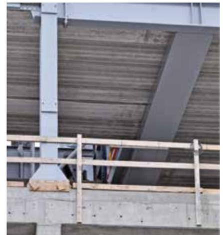
▲ DELTABEAM® Verbundträger können mit allen Deckensystemen kombiniert werden. In diesem Fall wurden Spannbeton-Hohlplatten eingesetzt.
