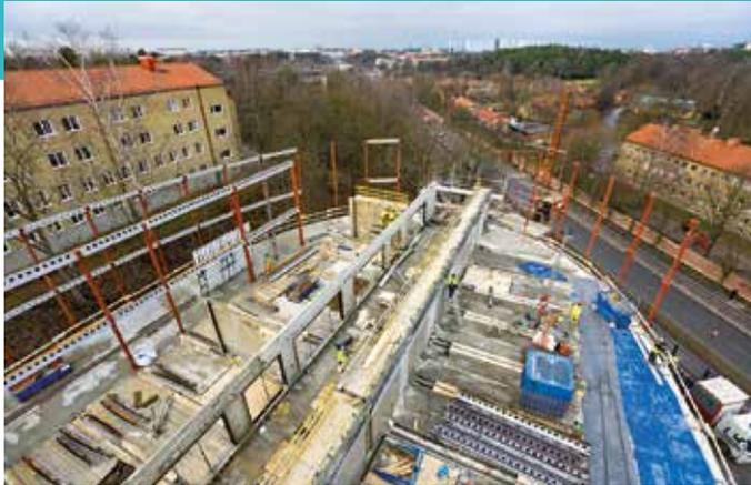
▲ Die DELTABEAM® Verbundträger sind entlang der Fassade und als Tragbalken zwischen verschiedenen Rahmentragwerken angeordnet. Insgesamt wurden 2.400 m DELTABEAM® auf die Baustelle geliefert.
