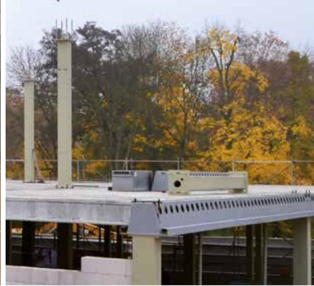
▲ Mit DELTABEAM® wird ein Versatz zwischen Deckenebenen mit Spannbeton-Hohldielen und Elementdecken realisiert. Die Verbundträger sind größtenteils in die Decke integriert. Die Verbundstützen des Obergeschosses werden an den Peikko Ankerbolzen der Verbundstützen im Erdgeschoss befestigt.
