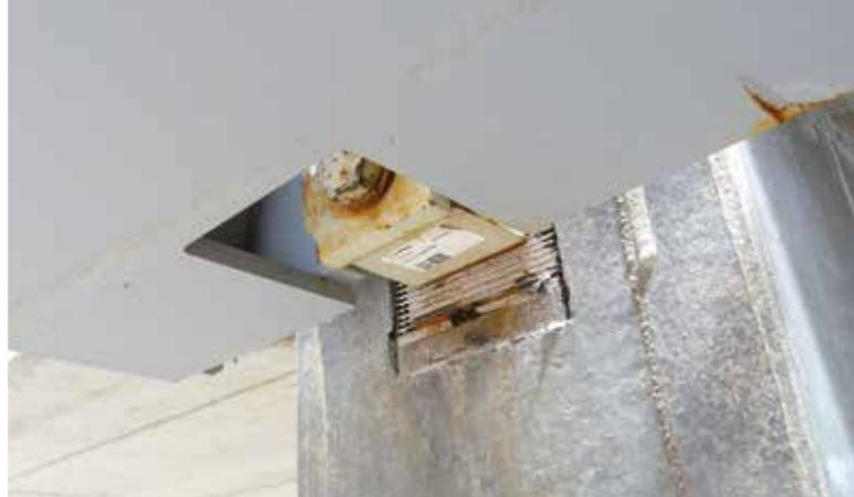
▲ PCs Konsolen ermöglichen die einfache und schnelle Montage der DELTABEAM® Verbundträger oder Fertigteil-Unterzüge an aufgehende Stahlbeton-Bauteile.
