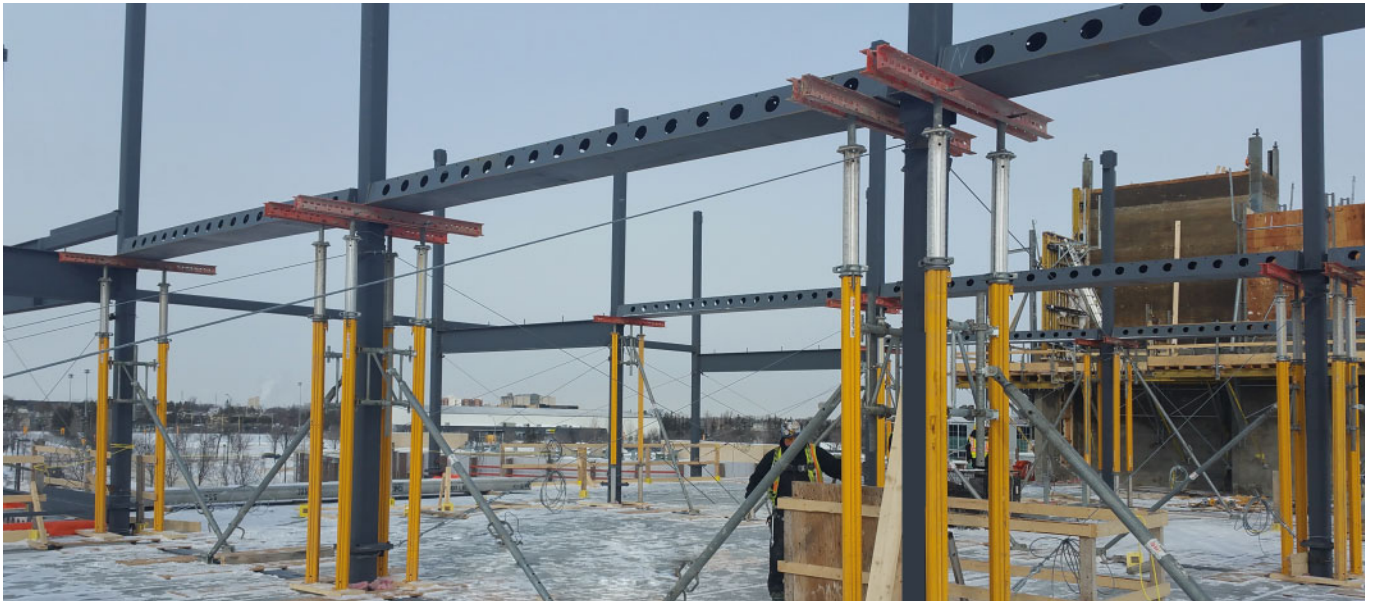
Abbildung 6. Abstützung des DELTABEAM®
