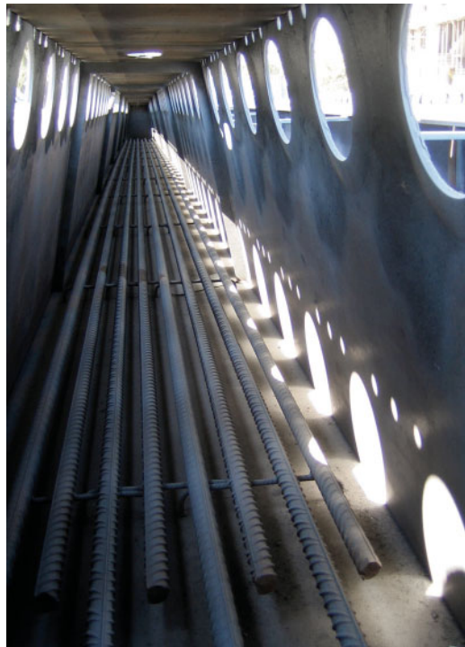
Abbildung 11. Brandbewehrung im DELTABEAM®
