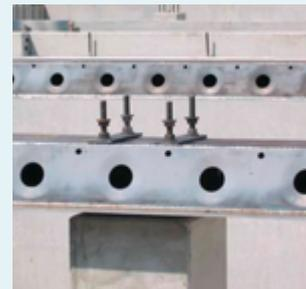
Ankerbolzen für eine Schraubverbindung zu Stahlbetonstützen
