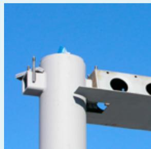
Stahlstütze mit Konsolenverbindung
