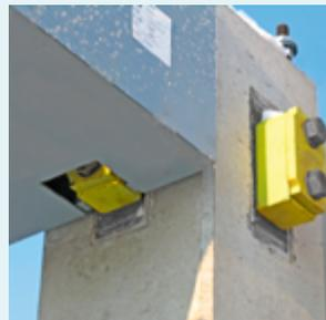
Anschluss an Stützen/Wände mit der versteckten PCs® Konsole
