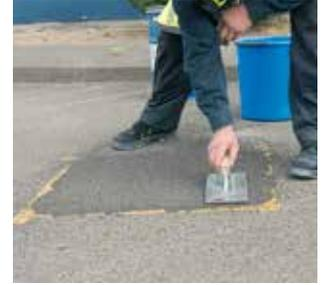
Der eingestreute Split kann zur Erhöhung der Haftung an das Triflex Asphalt Repro 3K mit einer Kelle festgedrückt werden.
