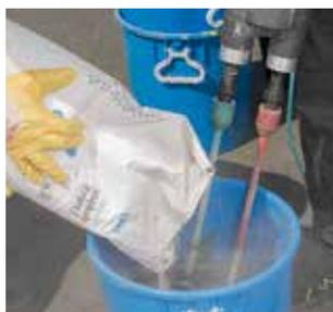
Triflex Asphalt Repro S Pulver mit doppelläufigem Rührgerät untermischen, bis die Homogenität der Komponenten gegeben ist.
