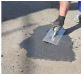
Mit einer geeigneten Kelle ist die Refillierung des Materials möglich. Bei Gefällesituationen > 2 % empfiehlt sich der Einsatz von Basisharz Triflex Repro R Basisharz THIX als Bindemittel.
