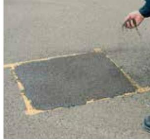
Zur optischen Anpassung an den Untergrund und zur Erhöhung der Griffbarkeit kann die sanierte Schadstelle im frischen Zustand mit Split im Überschuss abgestreut werden.
