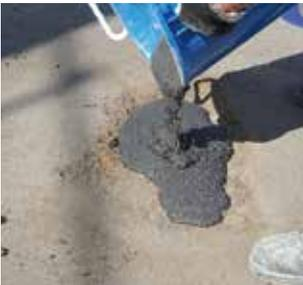
Das Schlagloch mit Triflex Asphalt Repro 3K im Mix 1 : 6 ver-füllen. Bei tieferen Schadstellen, die eine Sanierung mit hohen Schichtstärken erfordern, sollte lagenweise gearbeitet werden.
