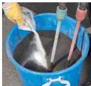
Danach den Triflex Katalysator zur Auslösung der Reaktion begeben und min. 2 Minuten gründlich mischen. Pro Gebinde Triflex Repro R Basisharz (4 kg) wird ein Beutel Katalysator (100 g) beige mischt.
