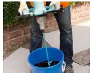
3. Triflex Repro R und Triflex Asphalt Repro S gut mischen, dann mit Triflex Katalysator ca. 2 Min. durchrühren.
