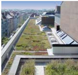
Triflex-Systeme lassen sich aufgrund ihres geringen Flächengewichtes und der vollflächigen Haftung auf alte Abdichtungen aufbringen. Eine Schutzlage ist nicht notwendig, da das Material hoch witterungsstabilisiert und chemikalienbeständig ist. Die Triflex-Flüssigabdichtung ist diffusionsoffen, so dass die bauphysikalischen Eigenschaften der vorhandenen Funktionsschichten nicht negativ beeinflusst werden.
