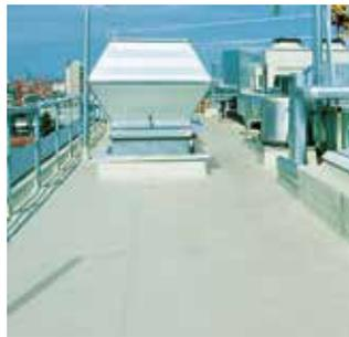
Triflex-Abdichtungssysteme haften auf bis zu ca. 90 % aller im deutschen Flachdachmarkt üblichen Untergründen. Das gibt Ihnen Sicherheit in der Materialkombination. Alle Triflex-Systeme sind hoch elastisch und tief-temperaturflexibel und besitzen durch eine Vliesarmierung hervorragende mechanische Eigenschaften. Die flüssige Verarbeitung garantiert die naht- und fugenlose Einbindung aller Details.
