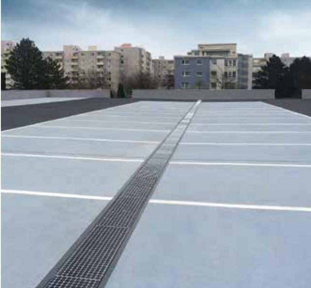
**Triflex ProPark** ist ein vollflächig vliesarmiertes Abdichtungssystem, das sich durch eine hohe Rissüberbrückung und Verschleißfestigkeit auszeichnet. Das mechanisch hoch belastbare System aus schnell reaktiven Polymethylmethacrylatharzen (PMMA), das speziell für den Parkhausverkehr entwickelt wurde, schützt das Bauwerk langzeitsicher. Das Parkdeck Abdichtungssystem Triflex ProPark besitzt ein allgemeines bauaufsichtliches Prüfzeugnis (abP) und ist nach OS 10 und OS 11a/b klassifiziert.
