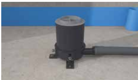
Ablaufposition festlegen, Montageschablone in Richtung Abflussrohr auflegen und Löcher für die Bohrungen markieren. Löcher bohren und den Ablaufkörper mittels Befestigungswinkeln und Schrauben an die Rohdecke fixieren.
