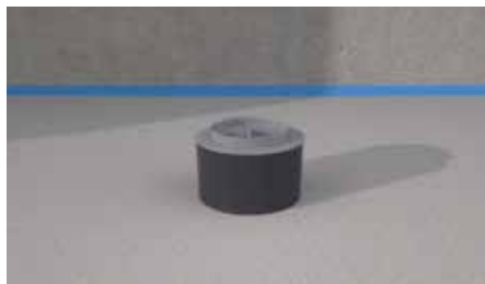
Fußbodenaufbau mit mindestens 2% Gefälle im Estrich herstellen
