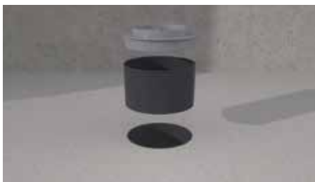
Den abgeschnittenen Rohrstutzen entfernen und die Bauschutzabdeckung in den Ablaufkörper einsetzen oder mit der Montage der Abdichtgarnitur fortsetzen.
