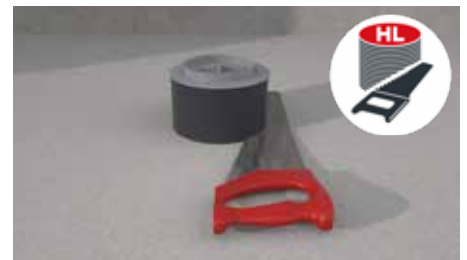
Nach dem Aushärten des Estrichs den herausstehenden Rohrstutzen estrichbündig abschneiden.
