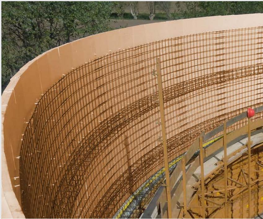
Konstruktion eines Fermenters zur Herstellung von Biogas mit Dämmplatten Typ SOPRA XPS SL.
