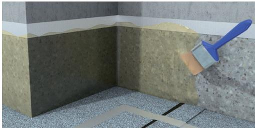
**2.** Fläche im Bedarfsfall gemäß Untergrundtabelle grundieren. Beschieferte Bahnen müssen nicht grundiert werden. Grundierung mittels Roller oder Pinsel, filmbildend auftragen. Nach der Applikation das Abdeckband sofort, im noch nassen Zustand der Grundierung entfernen.
