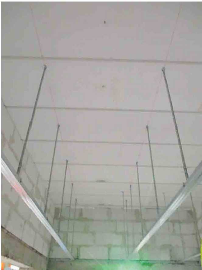
Aufbau der Decke im Prüfraum
