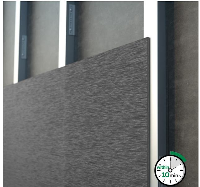
8. Befestigen Sie die Platte innerhalb von 10 Minuten nach dem Auftragen des Klebstoffs auf der Unterkonstruktion und drücken Sie sie fest an. Achten Sie darauf, den Mindestabstand von 8mm zwischen den einzelnen Platten einzuhalten und verwenden Sie eine Wasserwaage, um die korrekte Ausrichtung sicherzustellen.
