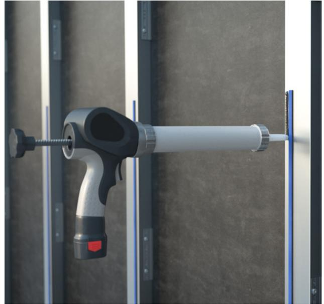
6. Tragen Sie Innotec® Adheseal Project Klebstoff mit der Accu Pistole auf die Unterkonstruktion auf. Achten Sie auf die richtige Positionierung und eine gleichmäßige Verteilung von Klebeband und Klebstoff. Lassen Sie 10mm Abstand zwischen dem Klebeband und der Kante der Unterkonstruktion.
