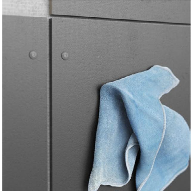
Zur Entfernung von trockenem Staub kann ein weiches, sauberes Tuch, eine sehr weiche Bürste oder eine Druckluftpistole verwendet werden. (Bohr-) Staub auf der Tafel sollte sofort entfernt werden. Wann immer möglich, sollte der entstehende Bohrstaub in geschlossenen Räumen direkt abgesaugt werden.
