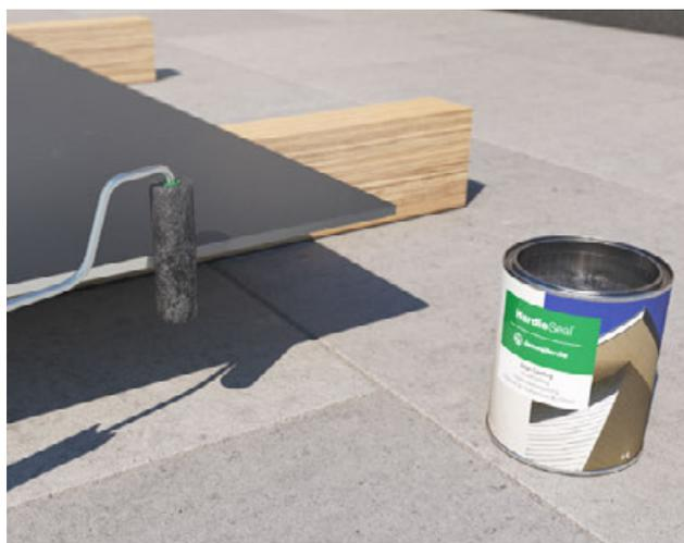
Zum Auftragen eignet sich ein Farbapplikator mit kleinem Schwamm, falls vorhanden mit einer dreieckigen Spitze oder eine feine Lackierwalze, da so am besten kontrolliert gearbeitet werden kann.
