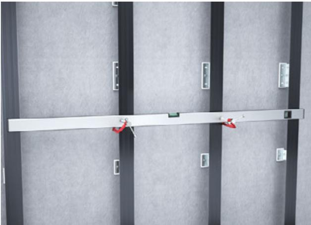
Die vorgebohrten Fassadentafeln können zur Montage auf ein zuvor ausgerichtetes Richtschiebe gestellt werden. Die Bohrung in der Aluminium-Unterkonstruktion kann mithilfe der Hardie™ Bohrlehre zentriert erfolgen.
