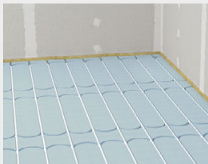
Einlegen der 16 mm Fußbodenheizrohre
