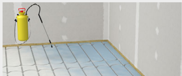
Grundieren der fermacell® Therm25™ Elemente mit fermacell™ Tiefengrund (unverdünnt)
