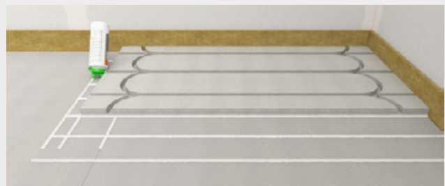
Kleberschnur für die Stoßfugenverklebung auftragen
