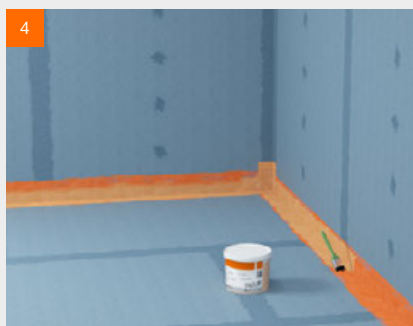
4 Dichtband direkt nach dem Eindrücken mit fermacell™ Flüssigfolie überstreichen
