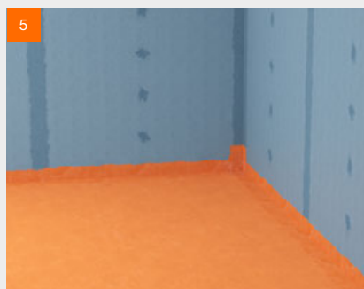
5 Vollflächige Abdichtung der Fläche im Bereich W1-I
