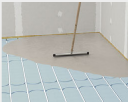
Ausgießen der Therm25™ Elemente mit fermacell™ Ansetzbinder
