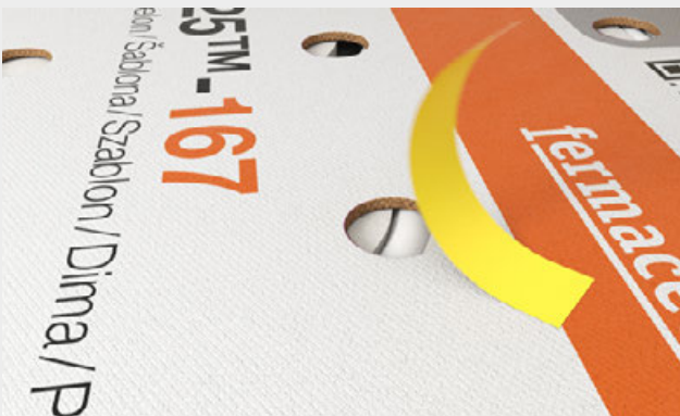
Auflegen der Schablone im geplanten Bereich der fermacell® Gipsfaserplatte als Abdeckplatte. Kontrolle, ob sich Heizrohre im Befestigungsbereich befinden. Falls ja, Befestigungspunkt mit Klebeband abdecken.
