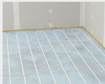
Fertig ausgegossene Therm25™ Elemente (Q1)
