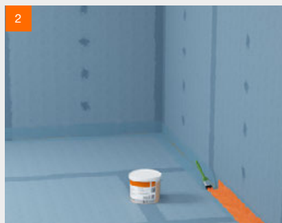
2 fermacell™ Flüssigfolie in der Ecke auftragen
