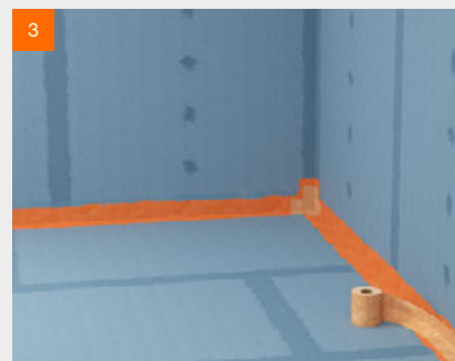
3 In die feuchte Flüssigfolie das fermacell™ Dichtband eindrücken
