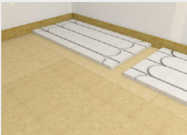
Verlegung der fermacell® Therm25™ Elemente (Variante 1) lose verlegt, stumpf gestoßen im Kreuzverbund
