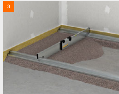
fermacell™ Gebundene Splittschüttung abziehen
