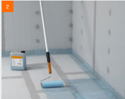
2 ... und Bodenbereich per Rolle auftragen - Trocknungszeit mindestens 2 Stunden
