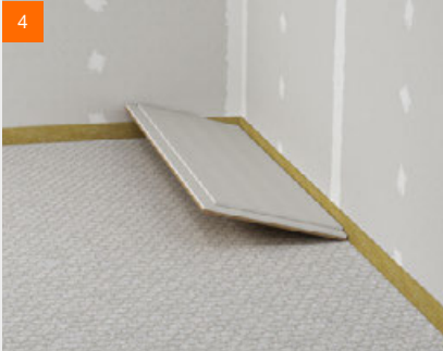
fermacell® Estrichelemente verlegen
