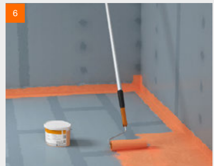
6 Dichtband direkt nach dem Eindrücken mit fermacell™ Flüssigfolie überstreichen - Trocknungszeit mindestens 1 Stunde
