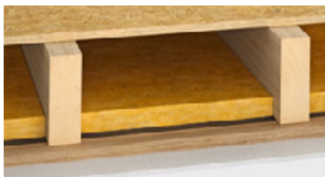
Geschlossene Holzbalkendecke, Unterdecke auf Lattung
