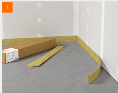
Anbringen der Randdämmstreifen
