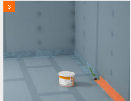
3 fermacell™ Flüssigfolie in der Ecke auftragen
