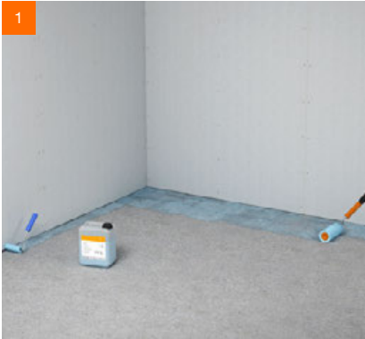
1 Grundierung des Untergrundes mit fermacell™ Tiefengrund
