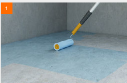
Vorbereitung: Boden grundieren
