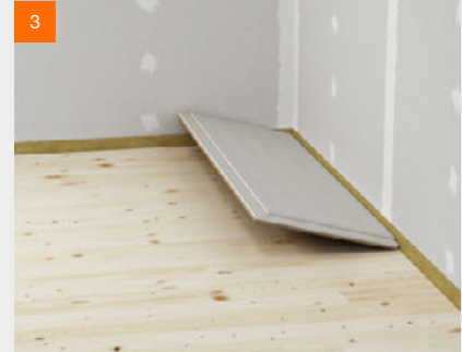
3 Verlegen der fermacell® Estrichelemente
