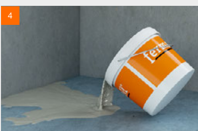
Boden-Nivelliermasse ausbringen und planeben nivellieren
