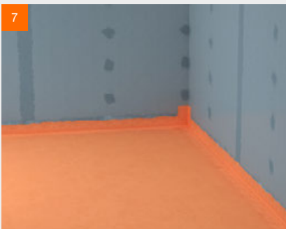
7 Bei der Verwendung von fermacell® Gipsfaser Estrichelementen in Klasse W1-I muss zusätzlich eine vollflächige Abdichtung erfolgen. fermacell™ Flüssigfolie mit der Rolle mind. 2x vollflächig auftragen (Trockenschichtdicke mindestens 0,5 mm). Gemäß DIN 18534-3 wird für den 2. Auftrag ein Farbunterschied zur besseren Nachvollziehbarkeit gefordert. 1. Auftrag: fermacell™ Flüssigfolie in Originalfarbe satt auftragen und trocknen lassen.
