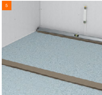
5 Ausrichten der Dämme und diese mit leichtem Druck verdichten
