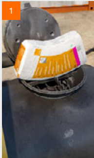
Mischungsverhältnis: 8 Säcke fermacell™ Wabenschüttung + 1 Gebinde fermacell™ Schüttungsbinder
