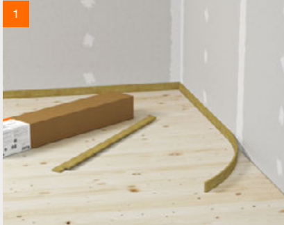
1 Randdämmstreifen verlegen und in den Ecken stumpf stoßen
