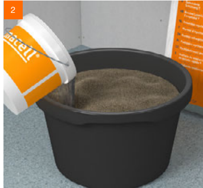
2 Der gesamte Sackinhalt ist in einem geeigneten Mischbehälter mit ca. 7-7,5 Liter Wasser ...
