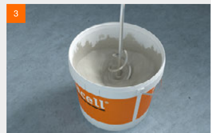
Mit geeignetem Rührgerät bei langsamer Drehzahl anmischen, bis eine homogene, klumpenfreie Nivelliermasse entsteht
