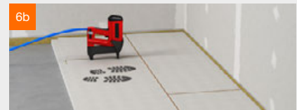
6a 6b Befestigen durch Verschrauben oder Spezial-Spreizklammern innerhalb von 10 Min.
