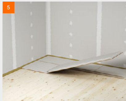
5 Verkleben der Elemente mit vollständig gefüllten Fugen
