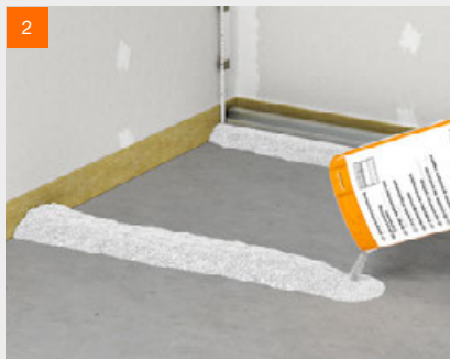
Anlegen der Dämme
