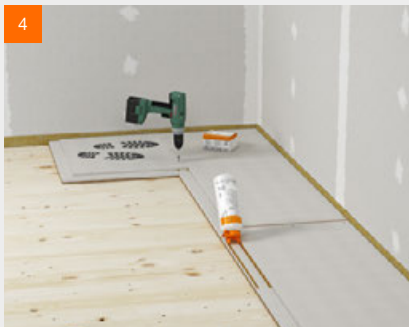
4 Auftragen des fermacell™ Estrichklebers im Falzbereich
