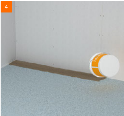
4 Anschließend hat die fermacell™ Gebundene Schüttung T eine erdfeuchte Konsistenz. Der erste Damm wird angelegt
