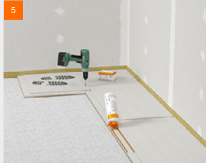
Verlegen der fermacell® Estrichelemente auf fermacell™ Ausgleichsschüttung
