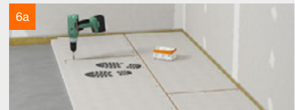
3 Verlegen der fermacell® Estrichelemente
