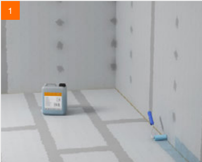
1 fermacell™ Tiefengrund im angrenzenden Wandbereich ...
