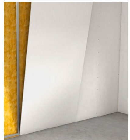
Bekleidung der Metallunterkonstruktion
