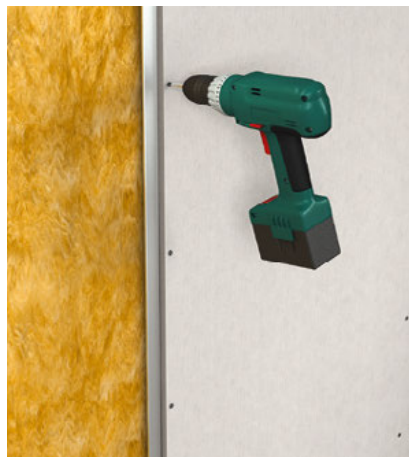
Befestigung mit Schrauben
