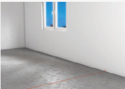
Anlegen der Wandachse mit Schnurschlag oder Hochbaulaser
