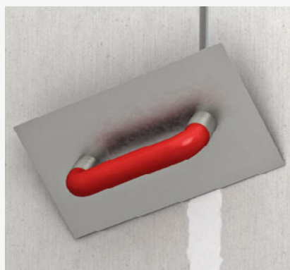
Fugen und Befestigungsmittel verspachteln
