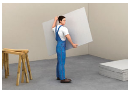
Einzelne fermacell® Gipsfaserplatten hochkant tragen
