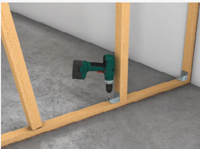
Montage der Holzständer mit Stiftnagel oder Stahlwinkel
