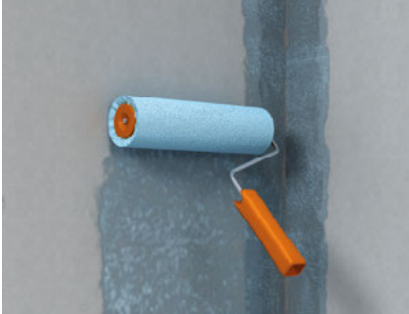
Abb. 1: Vollflächiges Aufbringen des fermacell™ Tiefengrunds – Trocknungszeit mind. 2 Stunden - Mischungsverhältnis: 1:1 bis 1:2 mit Wasser
