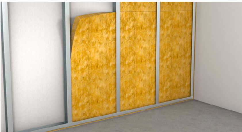
Einbringen der Dämmstoff-Platten
