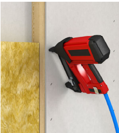
Bekleidung der Holzunterkonstruktion mit Klammern
