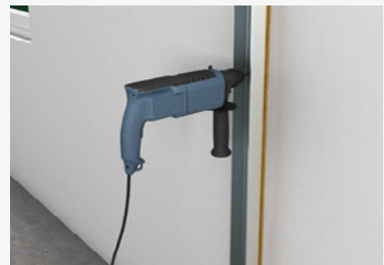
Befestigung der CW-Profile an Massiwand auf Dämmstreifen
