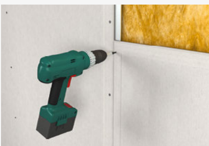
Schrauben auf Stahlunterkonstruktion
